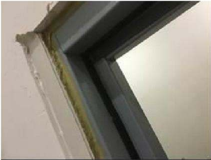
Puerta de Asturmex, se selló el marco con el muro
